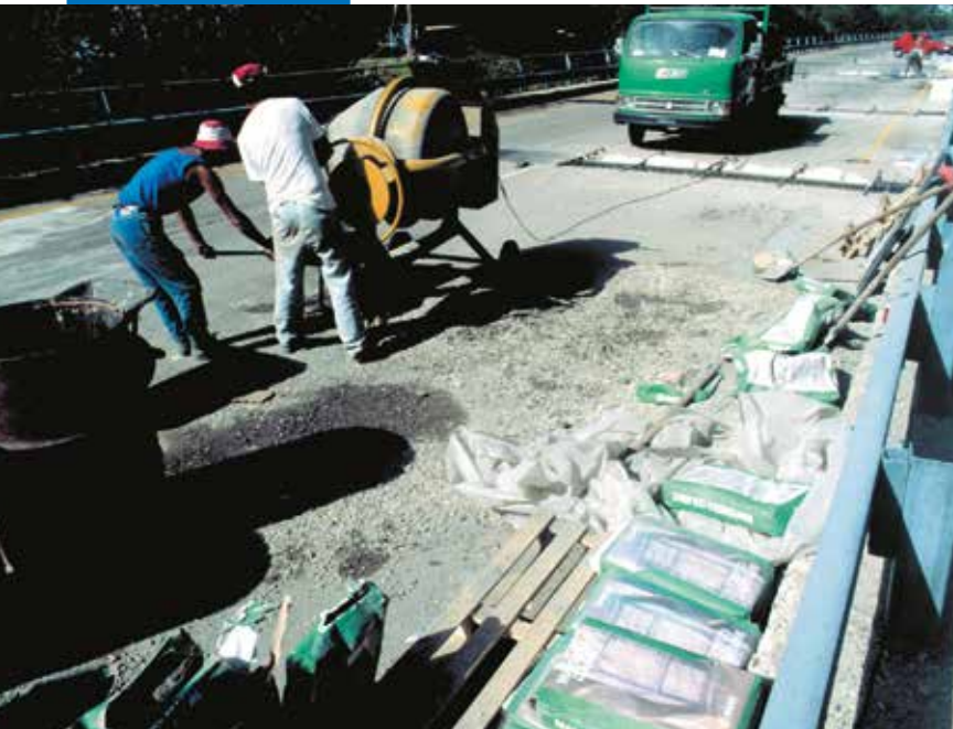
Herstellen van voegen in wegen
