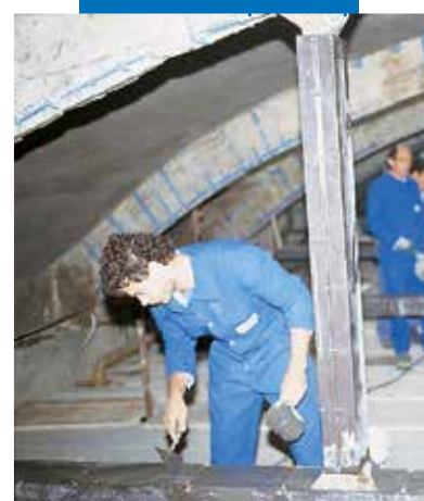
Gieten van Mapegrout Hi-Flow een metalen bekisting
