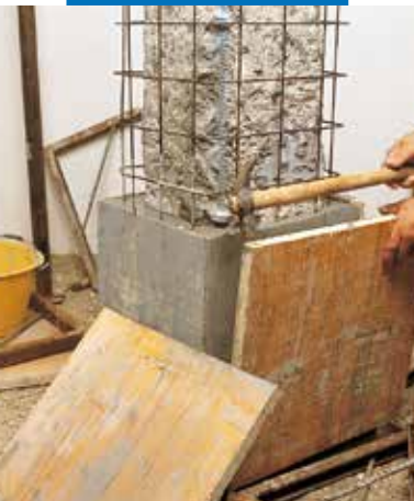
Verwijderen van de houten bekisting
