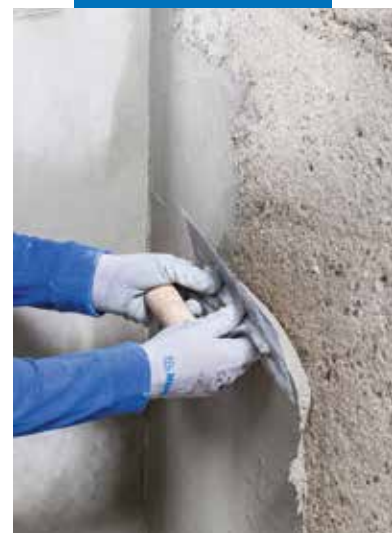
Application de Planitop Rasa & Ripara R4 à l'aide d'une lisseuse
