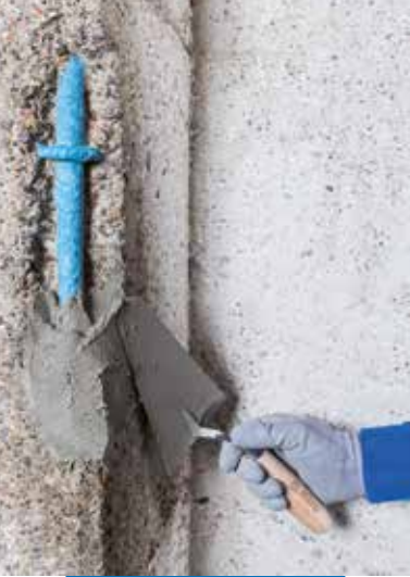
Application de Planitop Rasa & Ripara R4 à la truelle
