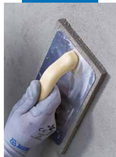
Ragréage de surface avec Planitop Rasa & Ripara R4 à l'aide d'une taloche-éponge
