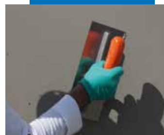
Aanbrengen van de 1 ste laag met een spatel 2 de laag na 1 uur (bij +20°C)
