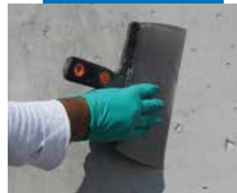
Verwijdering van onregelmatigheden met een spaan
